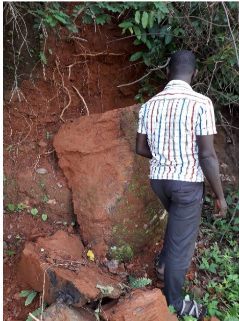
Photo 5 : Eboulement de blocs de micaschistes altérés
