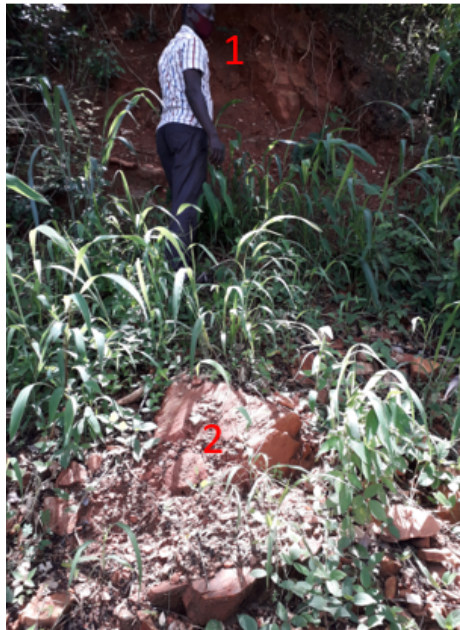
Photo 3 : Glissement de terrain matérialisé par une niche de décollement (1) et les matériaux déplacés (2)
